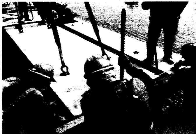
Foto 11: Transporte y colocación de losas en cabezo de muelle.
