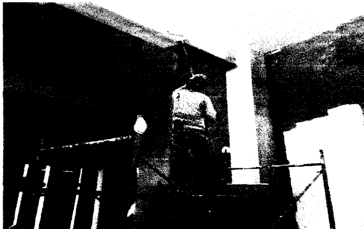
Foto 18: Pintura en muros, columnas, vigas vestiduras de derrames, etc.
