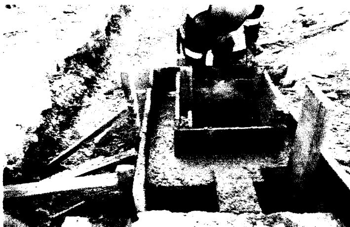
Foto 06: Buzones y cajas para instalaciones eléctricas y instalaciones sanitarias.
