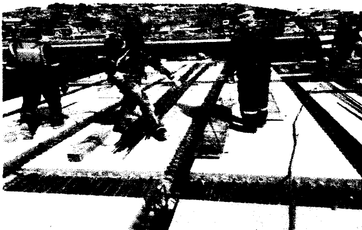
Foto 13: Encofrados de juntas en cabezo de muelle.
